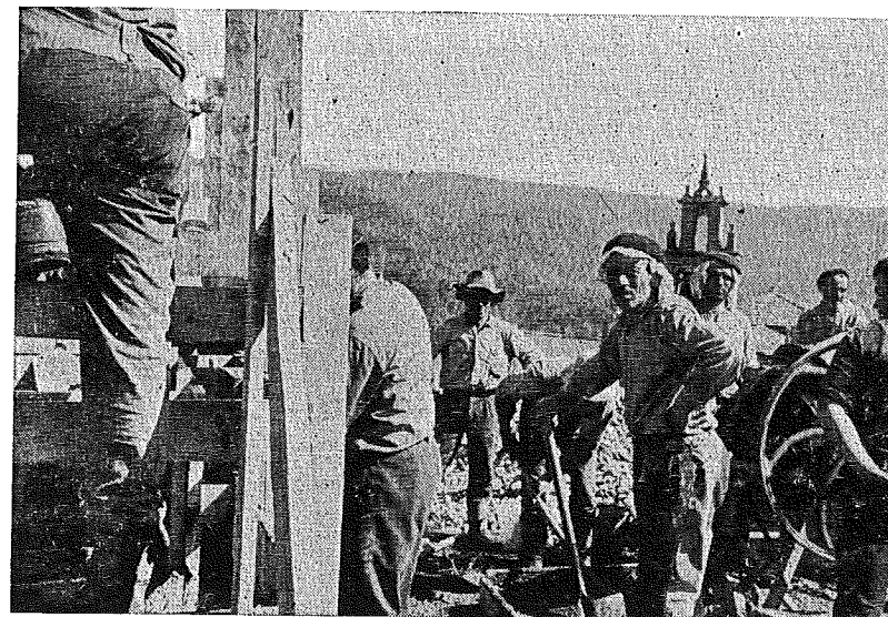
Todos los vecinos unidos, con sus propios medios, construyen una traída de aguas para uso doméstico.
