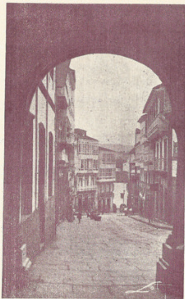
CALLE DE SANCHEZ BREGUA Y ENSANCHE DE PORTAL
