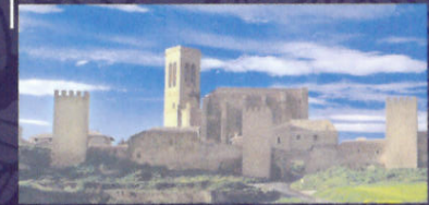
RESTAURACIÓN DEL SANTUARIO DE SANTA MARÍA, UJÉ.
