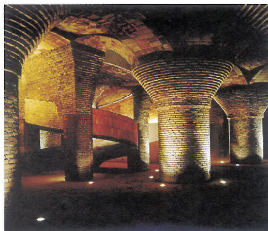
Restauración del Palau Güell (Barcelona).
