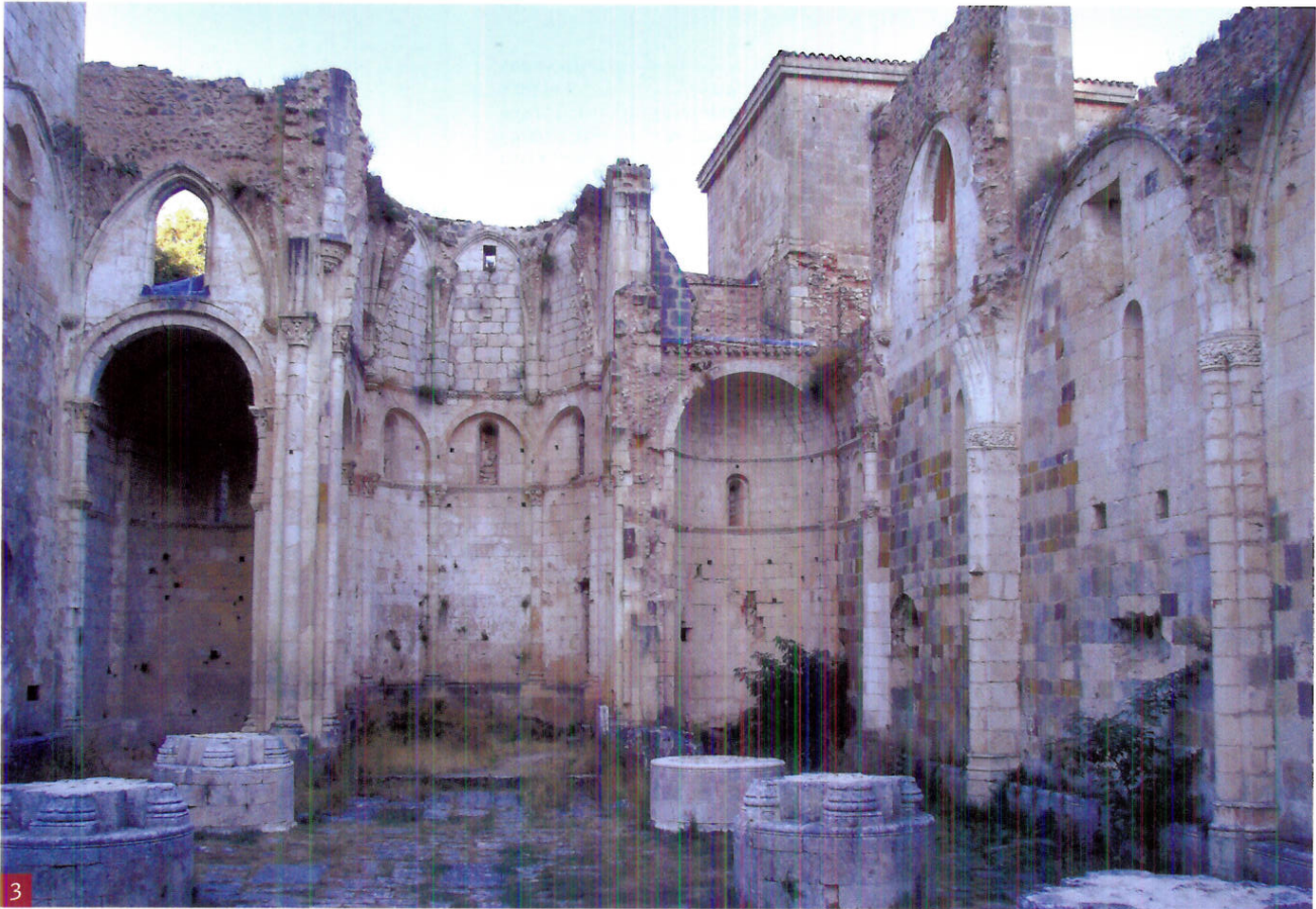
03. Ruinas de la cabecera y naves de la iglesia del Monasterio de San Pedro de Arlanza (Burgos)
