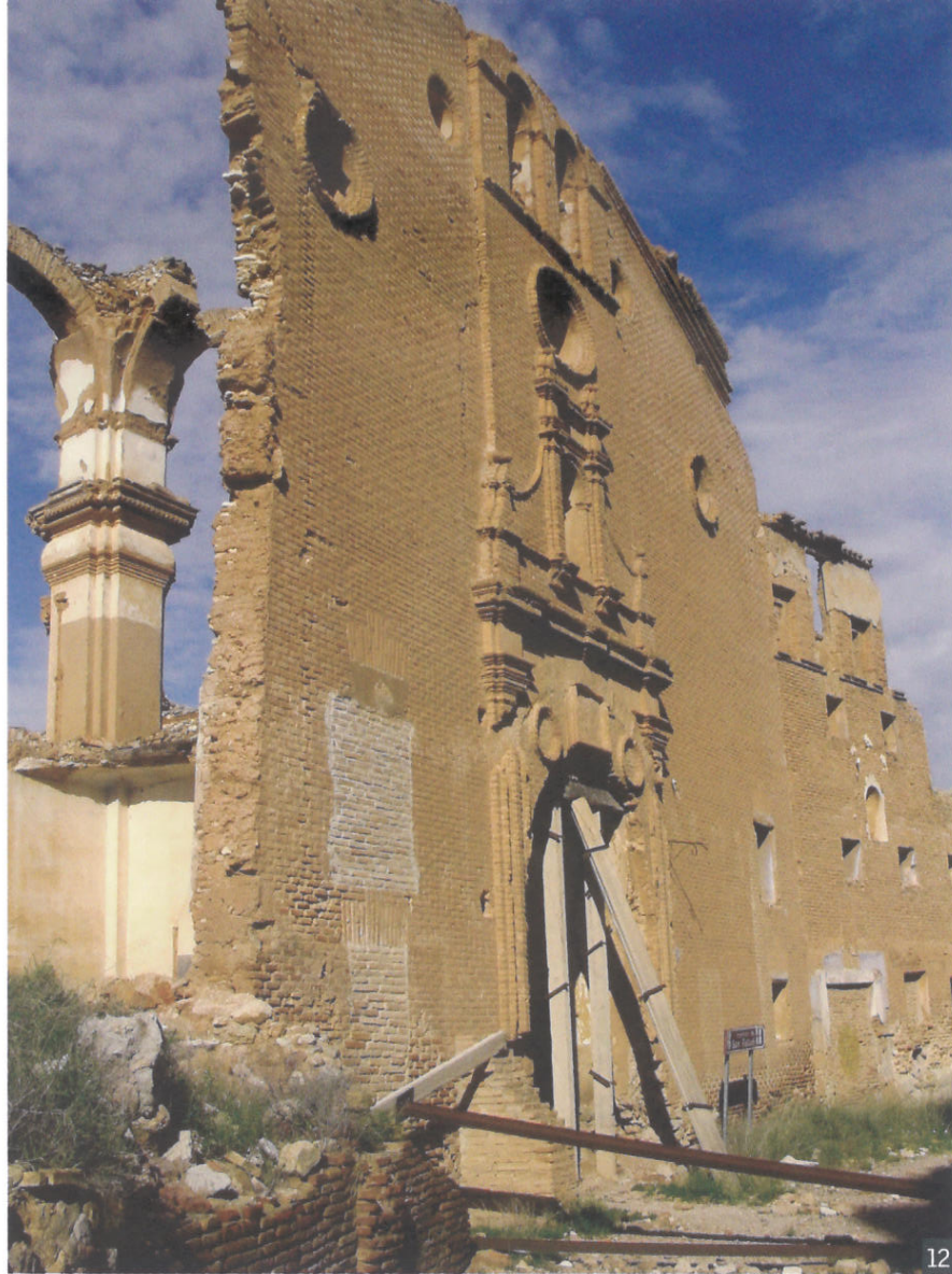
11. Detalle del interior de la Torre del Reloj, Belchite (Archivo BAU).
