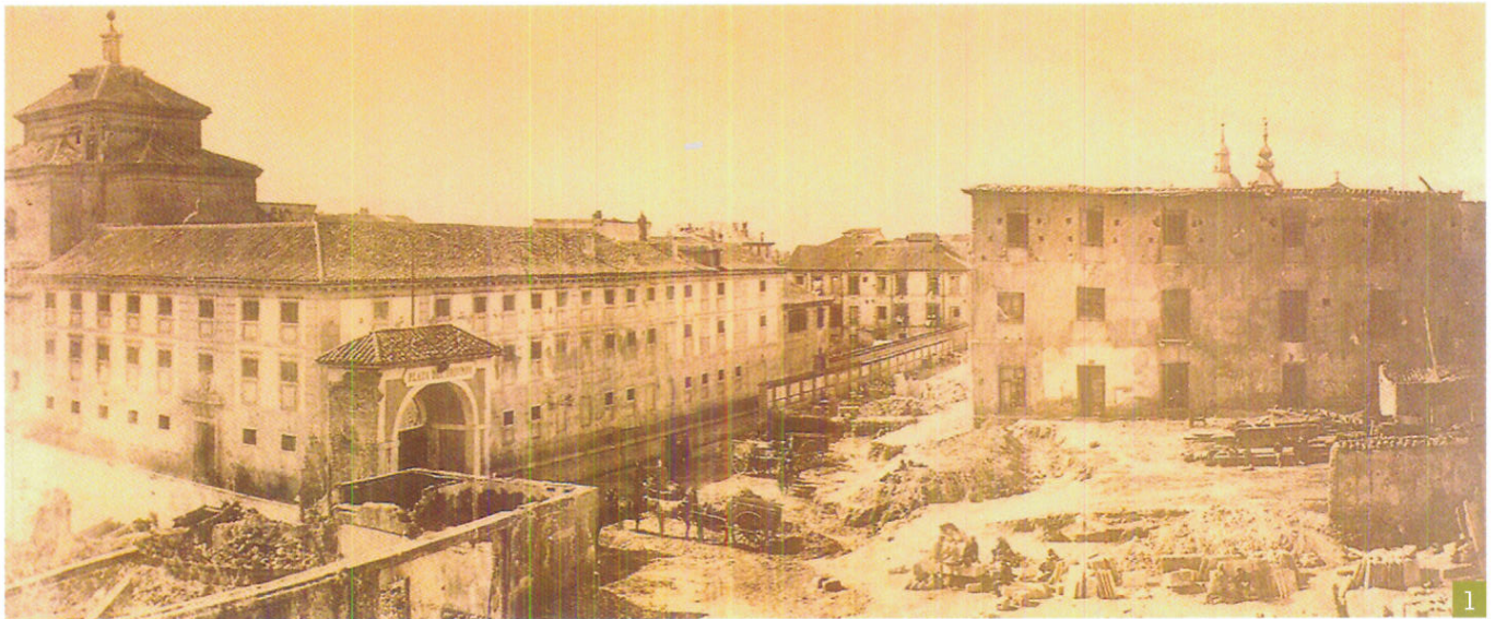
1. Fotografía de Laurent. Demolición del Parque de Artillería de Monteleón en 1869. A la izquierda se distinguen el arco de entrada al Parque y, al otro lado de la calle, el convento de Nuestra Señora de las Maravillas. A la derecha el edificio principal del cuartel. Por detrás, sobre su cubierta sobresalen la torre de la iglesia de Montserrat, el remate de su fachada y la cúpula de la iglesia de las comendadoras de Santiago. Fotografía de Laurent. Museo de Historia. Publicado en Imágenes de Madrid (Fondos fotográficos del Museo Municipal), Madrid, 1984.
