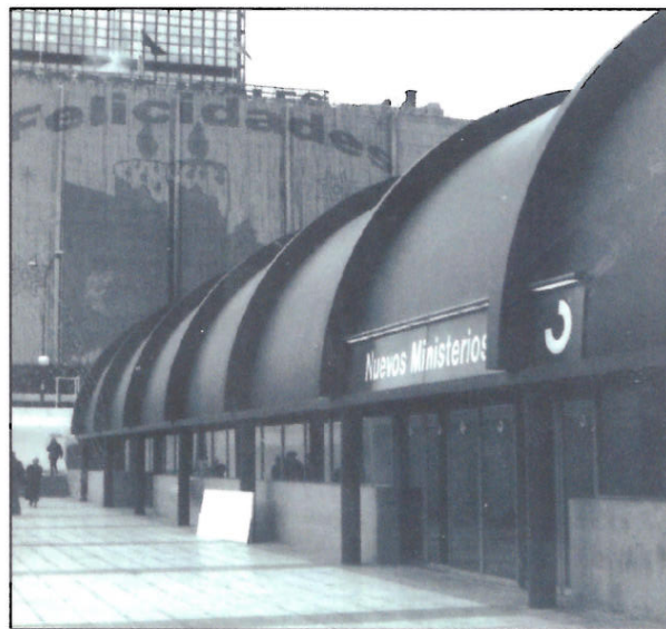
REHABILITACIÓN INTEGRAL DE LA ESTACIÓN DE RENFE DE NUEVOS MINISTERIOS Y CREACIÓN DE NUEVAS CONEXIONES CON LA RED DE METRO (MADRID)
