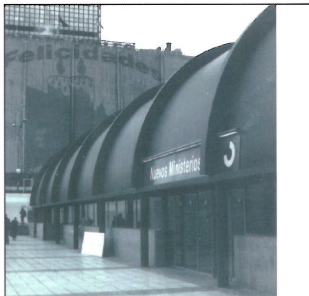
REHABILITACIÓN INTEGRAL DE LA ESTACIÓN DE RENFE DE NUEVOS MINISTERIOS Y CREACIÓN DE NUEVAS CONESIONES CON LA RED DE METRO (MADRID)
