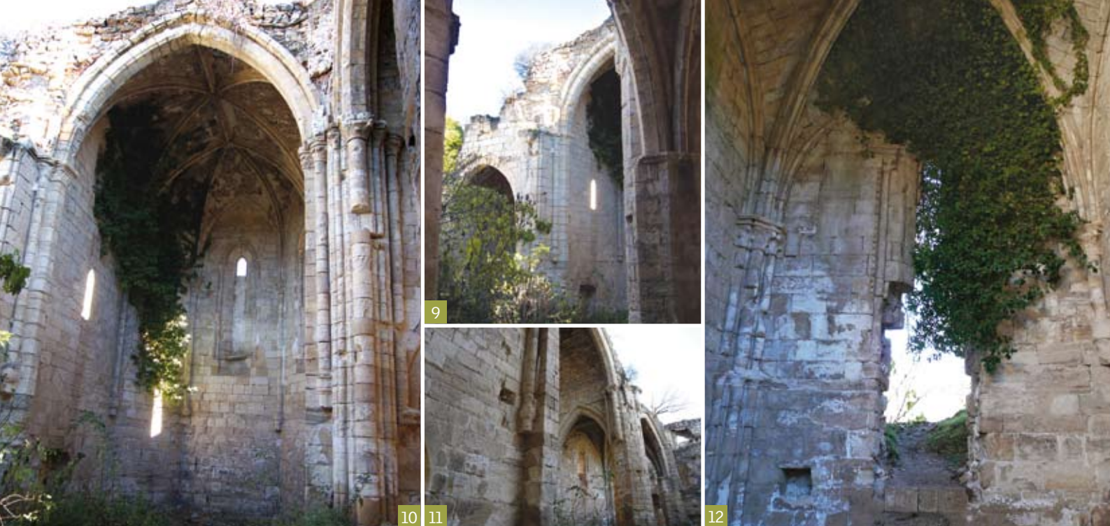
9. Vista interior desde la nave sur de la iglesia. Se observa el ábside de la Iglesia y la ausencia de cubierta en la nave principal.
