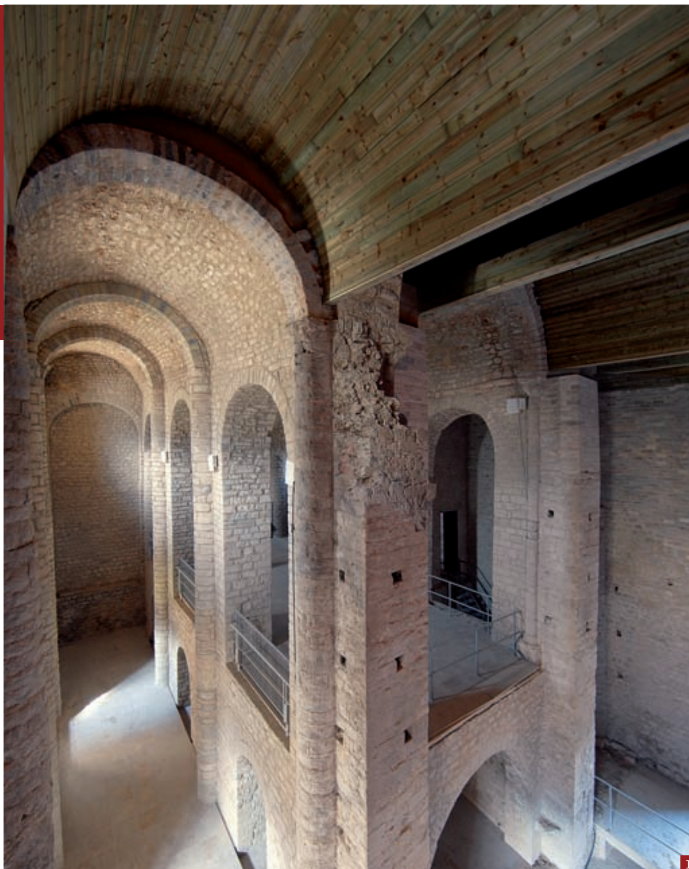
1. La imagen corresponde a la restauración-reconstrucción del monasterio medieval de Sant Llorenç, en Guardiola de Berguedà (Barcelona) arquitecto: Antoni González Moreno-Navarro. 1998-2008. fotografía: Montserrat Baldomà.
